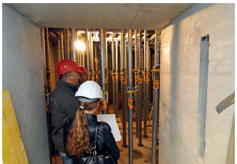
Bild unten: Für die Stabilisierung der Decken während des Betonierens wurden über 130 Stützen mit einer Stützlasterlast von jeweils drei Tonnen benötigt.
